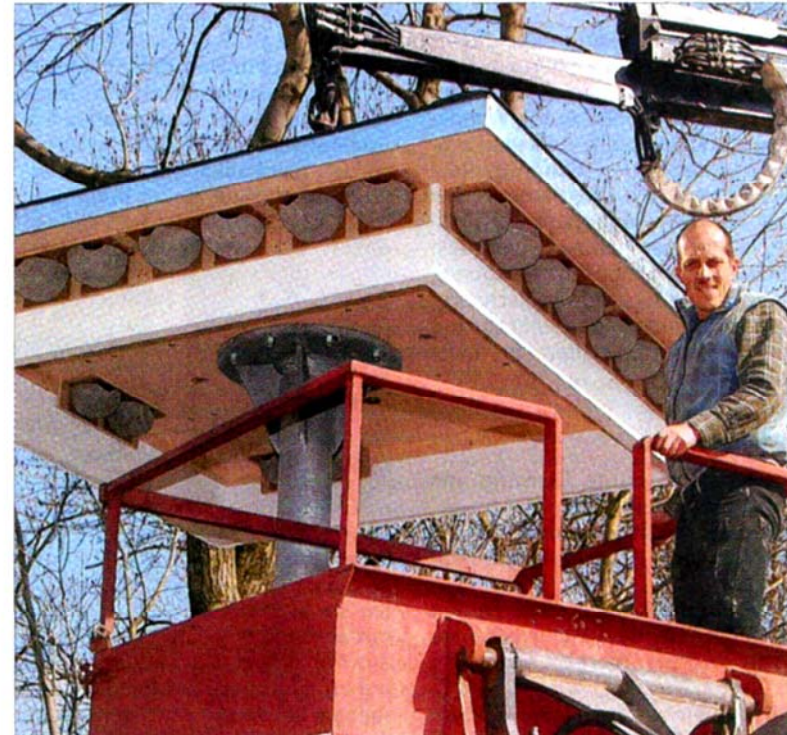
Das neue Domizil der Süßener Mehlschwalben-Kolonie wurde gestern in der Jahnstraße montiert. Foto: Dierk Böttcher
